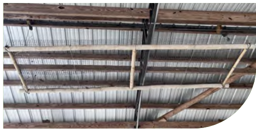
Una rejilla suspendida cerca de un techo metálico
