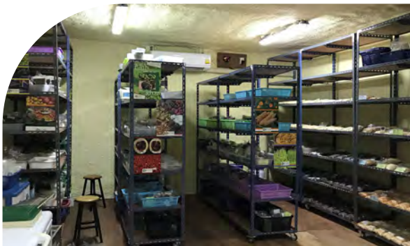
Un almacén de semillas en Asia refrigerado con un sistema CoolBot.
