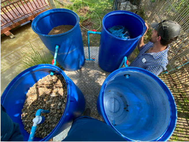
Figura 12. Construcción de filtro de bioarena. Fuente: Personal ECHO Asia
