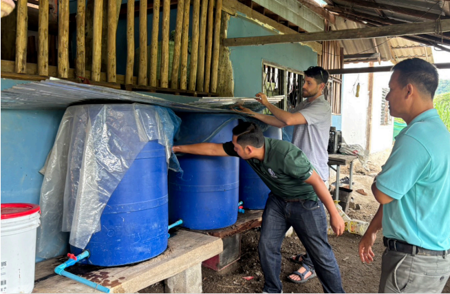
Figure 10. Vérification d'un filtre à sable biologique et prélèvement d'échantillons d'eau dans le village de Pangfan. Source: Personnel de ECHO/Asie
