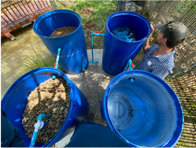
Figure 12. Construction d'un filtre à sable biologique. Source: Personnel de ECHO/Asie
